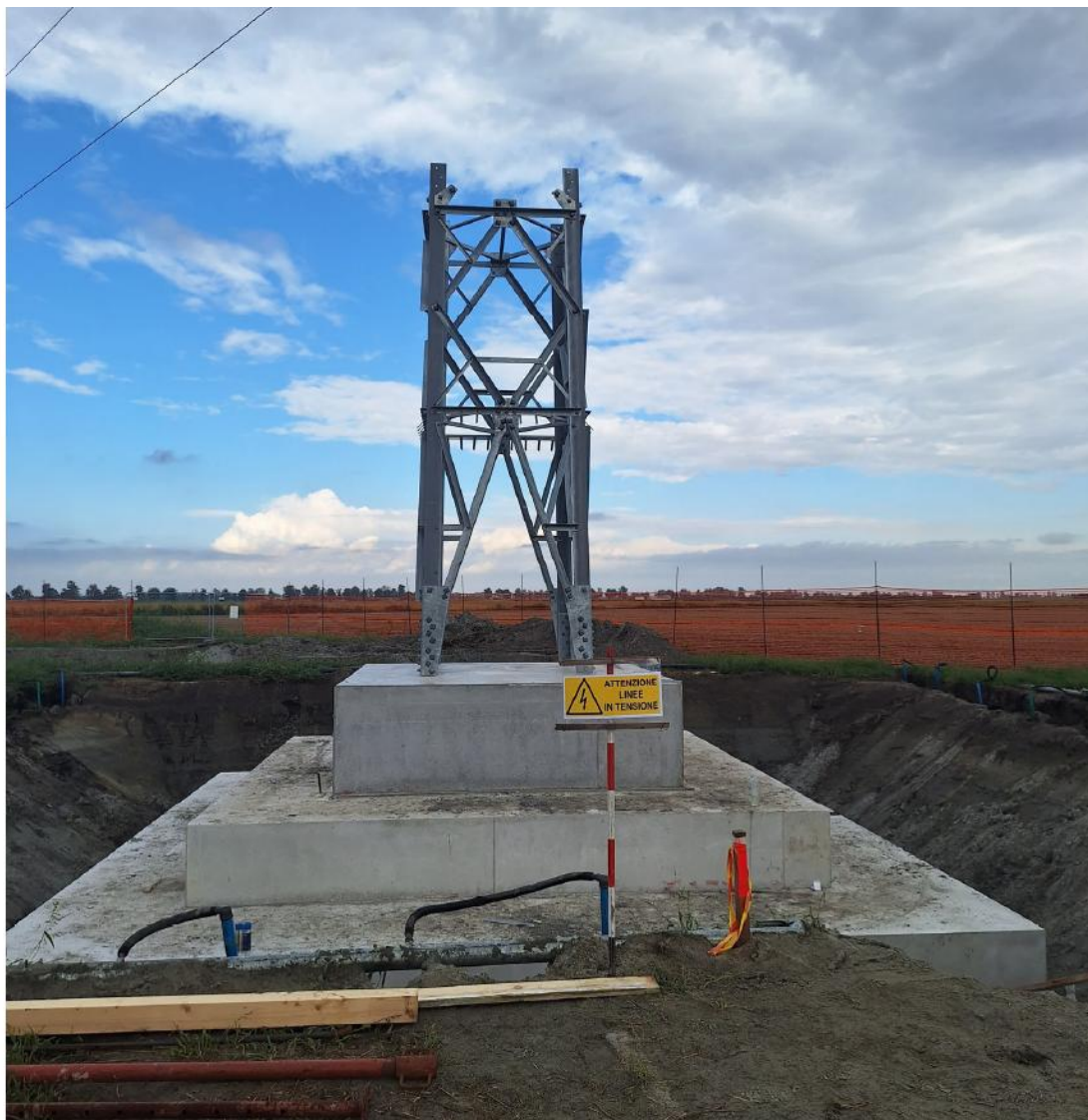
Figura 4.44: Esempio fondazione monoblocco
